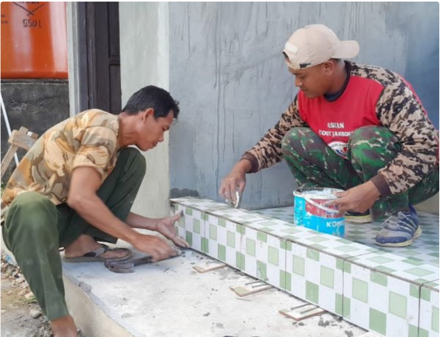
Tak Kenal Lelah, Pengerjaan Rehab TPA Terus Di Kebut
