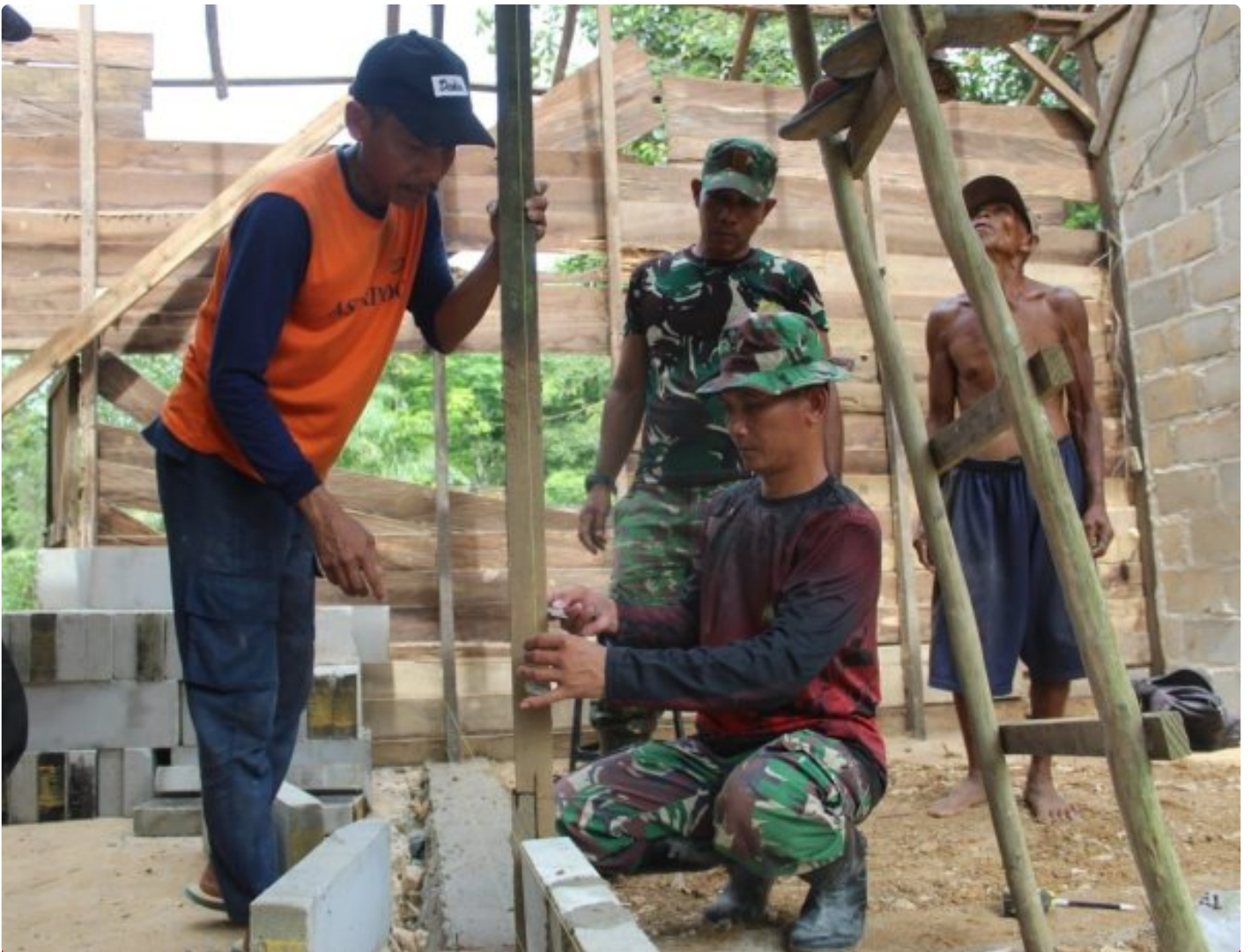
Sasaran Bedah Rumah, Sudah Tahap Pemasangan Dinding
