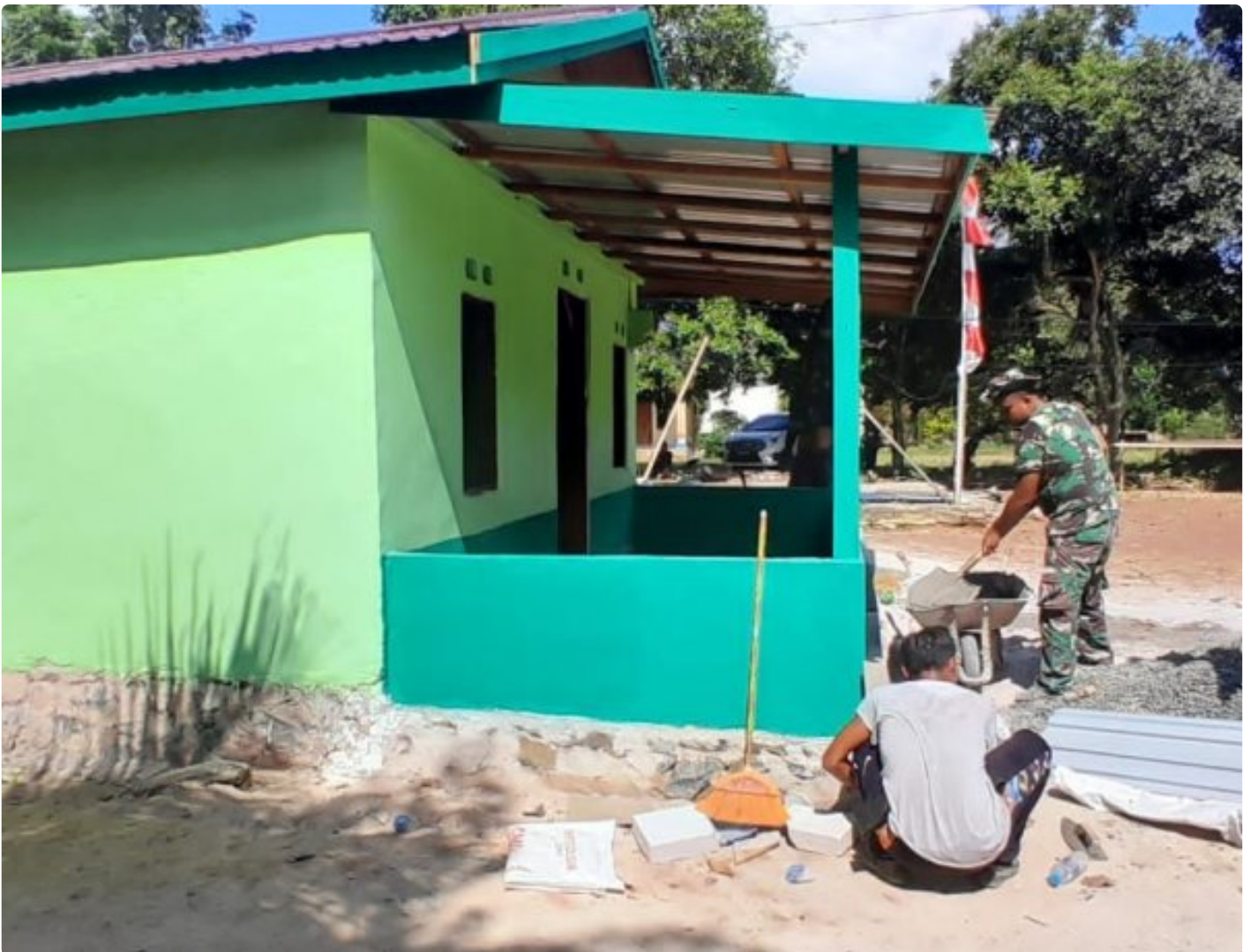
Pengerjaan Rumah Mbah Sandi Hampir Rampung
