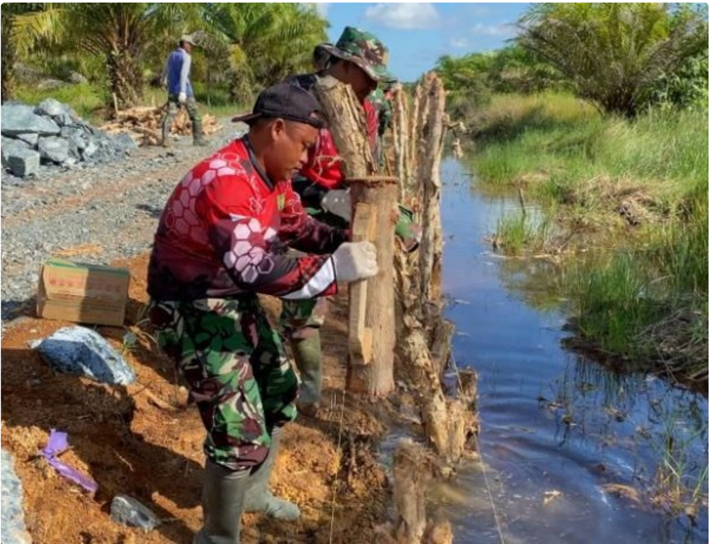
"Kayu Galam" Potensial Untuk Landasan Pemasangan Pondasi
