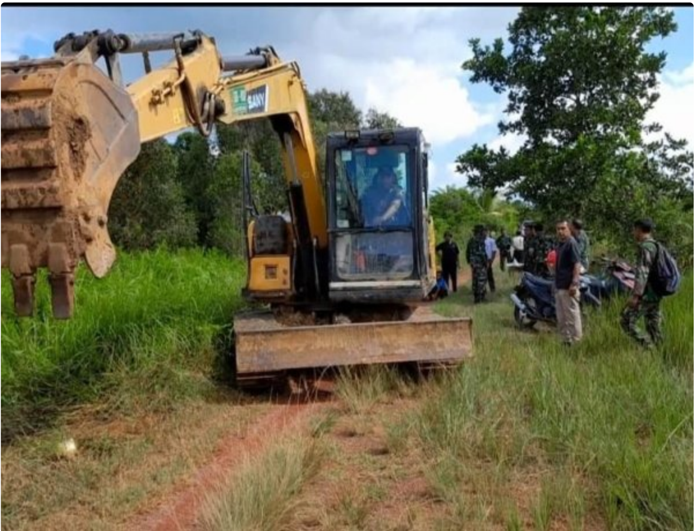
Dandim 1009/Tla, Turunkan Excavator Di Lokasi TMMD
